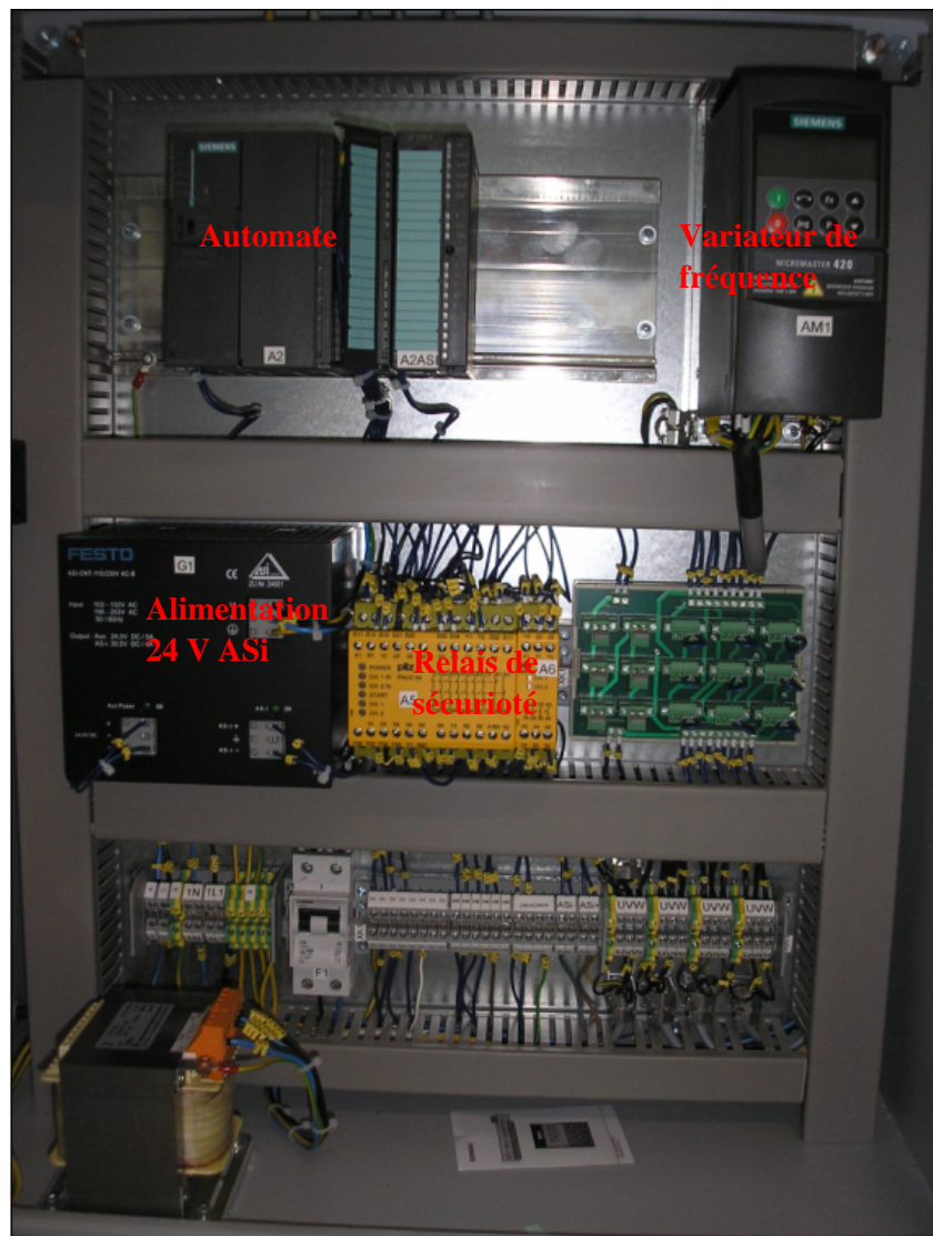
Coffret central du convoyeur central
