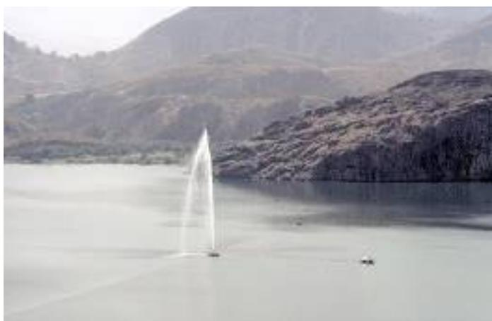
**Figure 2:** Sous l'action d'un processus de pompage auto entretenu, un jet d'eau surgi des profondeurs du lac Nyos permet de drainer le CO<sub>2</sub> dissous enfoui dans ses profondeurs.
