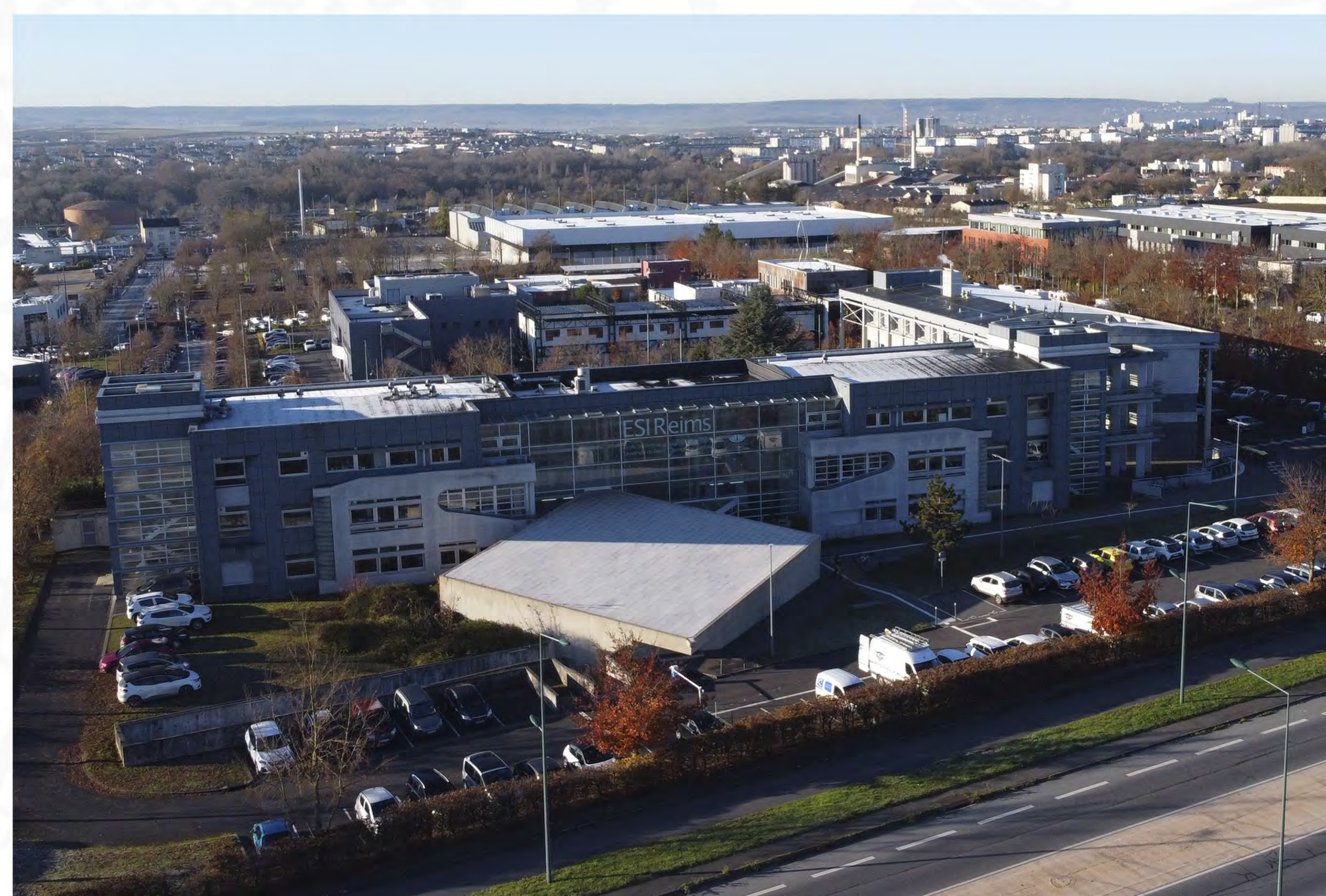
Ecole nationale supérieure d'ingénieurs de Reims
