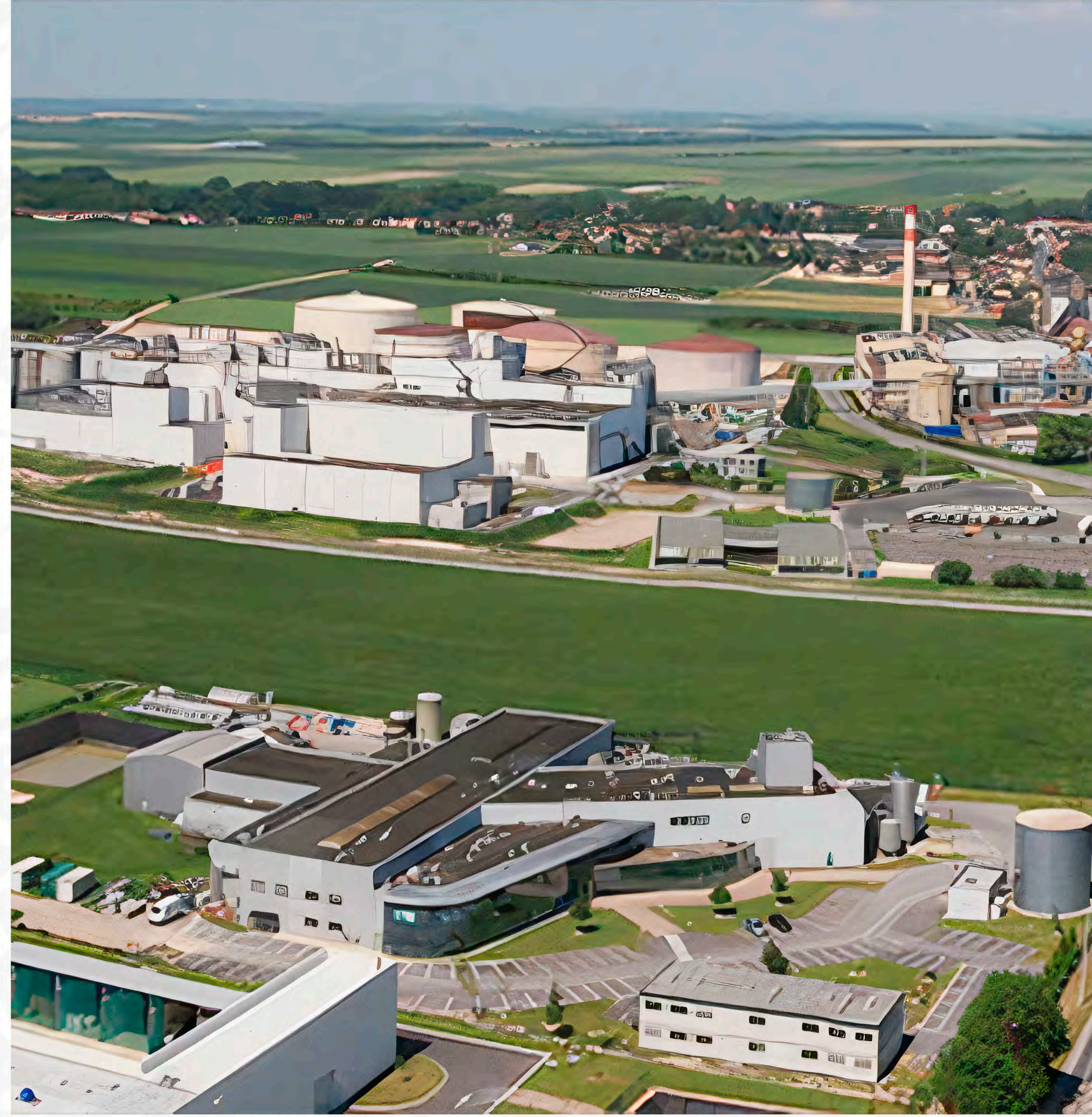
www.grandreims.fr. La bioraffinerie de Bazancourt-Pomacle
