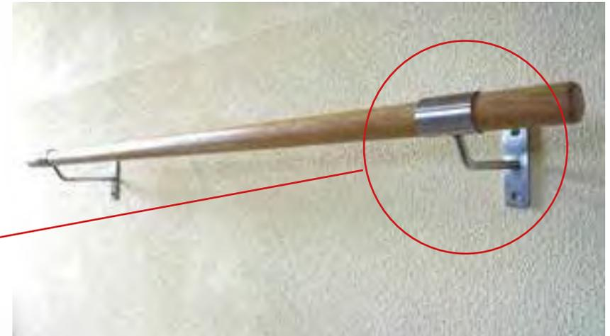
Mise à distance/ rampe en bois diamètre de 50 mm de diamètre
